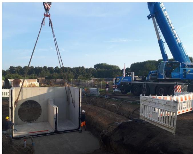
Abb. 6: Trennbauwerk Fertigbetonteil
