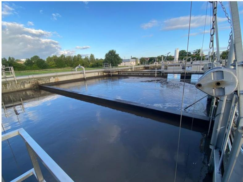
Abb. 2: Abgesenkte Biologie mit sichtbarer Überlaufkante
