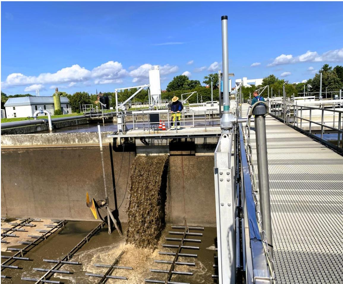
Abb.: Erneuerung der Belüfterelemente in der Belebung der Kläranlage Zittau
